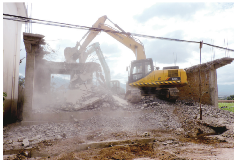
6月5日,强制拆除“两违”建筑现场。
