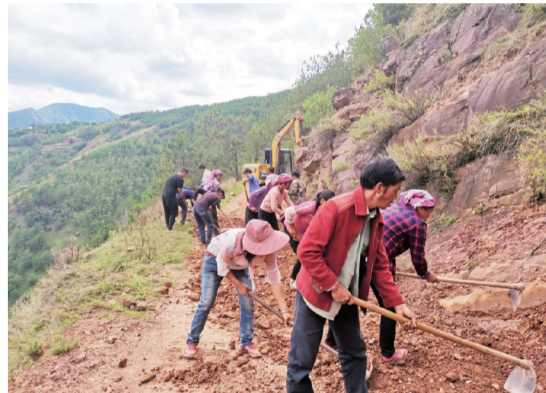
宾川县平川镇帽角山村村委会群众正在清理养护进村公路。(摄于7月30日)自7月20日以来,宾川县交通运输局组织党员干部、驻村工作队员及村组群众对帽角山村村委会干线公路、村组道路进行清理养护。 [通讯员 张义红 杨进礼 摄影报道]
