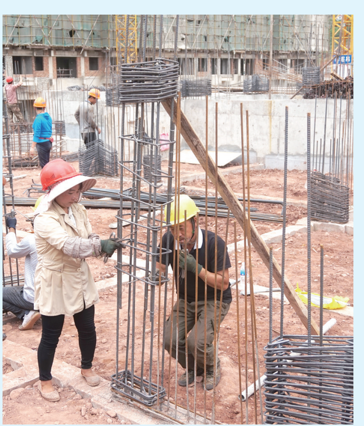
永平县城“博悦府”商住小区房地产项目施工现场。(摄于7月28日) 近年来,随着一栋栋风格迥异的住宅楼拔地而起,一个个别具特色的生态绿色住宅小区相继落成,不仅使永平人民有了更加温馨舒适的居所,而且促进了县域经济发展。1至6月,永平县房地产开发在建项目9个,总建筑面积77万平方米,完成房地产投资5.93亿元。 [通讯员 张馨摄]
