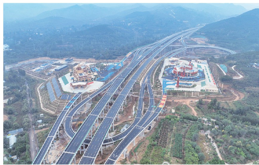
9月24日在山东省青州市拍摄的济青高速济潍段仰天山互通立交(无人机照片)。当日，由山东高速集团投资建设的济青中线济潍段零碳智慧高速正式通车，至此，济青中线全线贯通。济青中线济潍段是山东省“九纵五横一环七射多连”高速公路网中“射三”线，全长161.86公里，设计速度120公里/小时，双向六车道。
