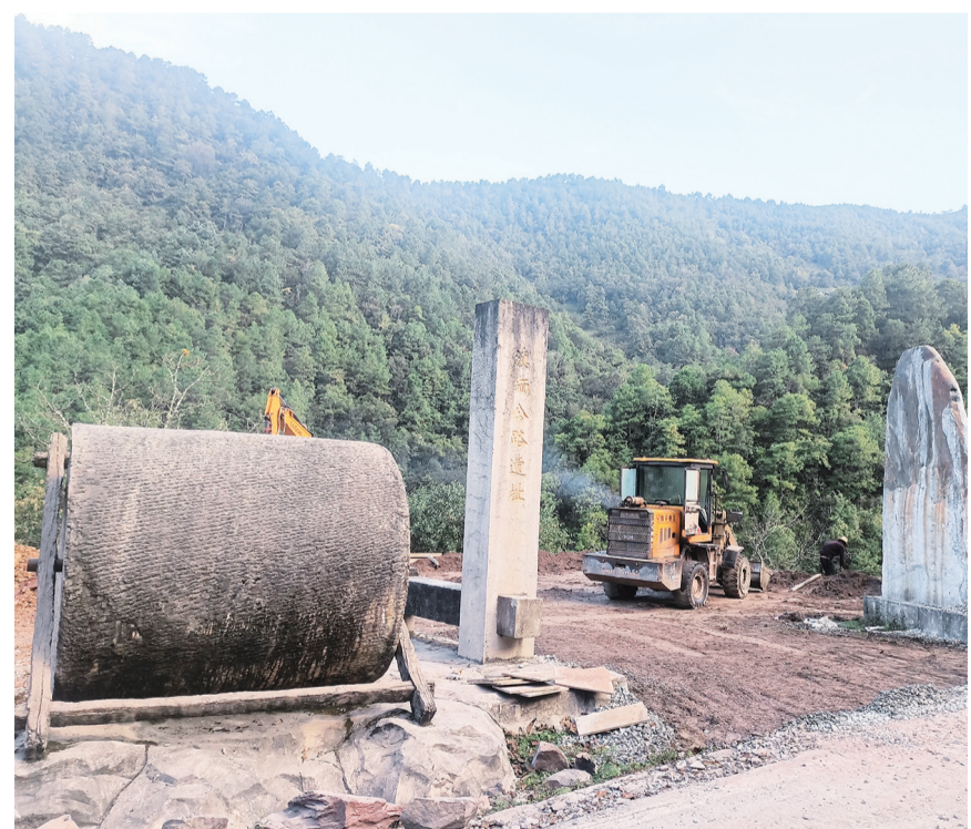
施工中的漾濞县太平乡2023年沪滇携手乡村振兴结对帮扶建设项目。(摄于10月23日)
