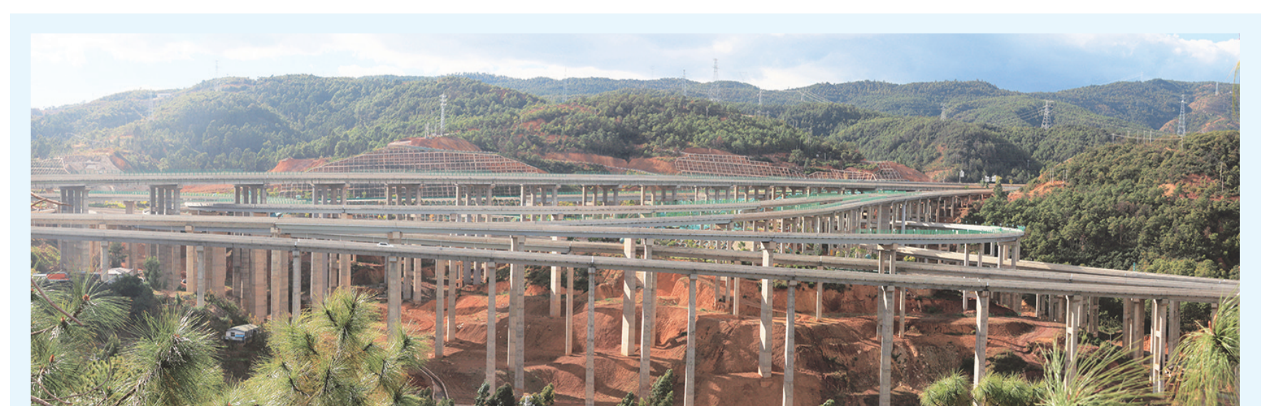
祥云县浑水海沟轮型互通式立交桥。(摄于12月9日) 浑水海沟轮型互通式立交桥由1座主线桥、8条匝道、22座多种类型的桥梁构成,主要连接新建(雄)大(理)高速公路、祥(云)姚(安)公路、宾(川)南(涧)高速公路主线及匝道,是云南省在建高速公路最大的枢纽立交。
