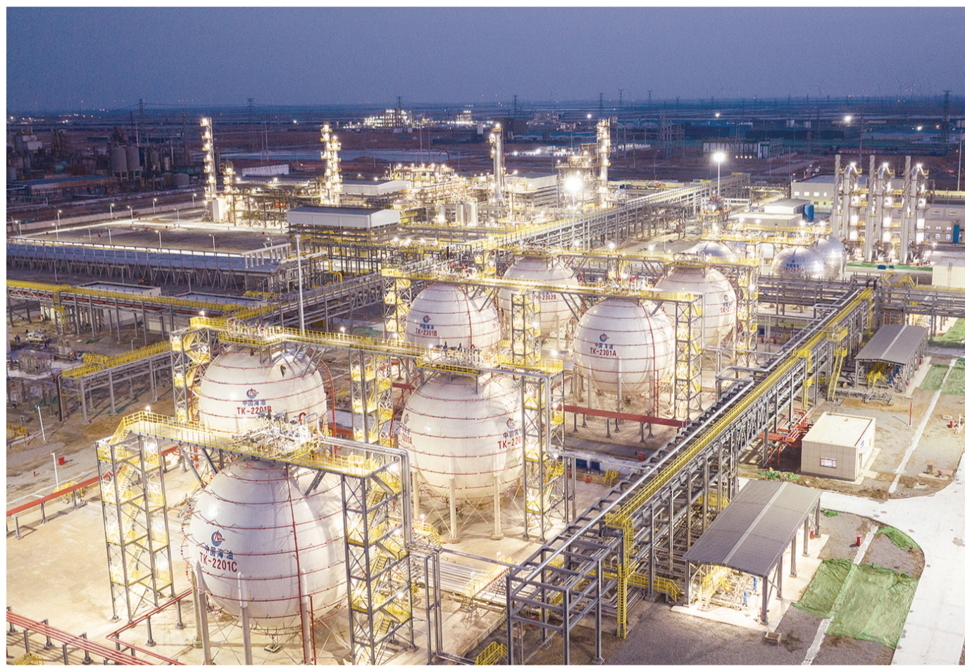
这是3月18日拍摄的滨州天然气处理厂一角(无人机照片)。当日，渤海油田最大天然气处理厂——位于山东的滨州天然气处理厂正式向环渤海地区供气，我国北方海上油气资源外输和保供能力取得新突破。
