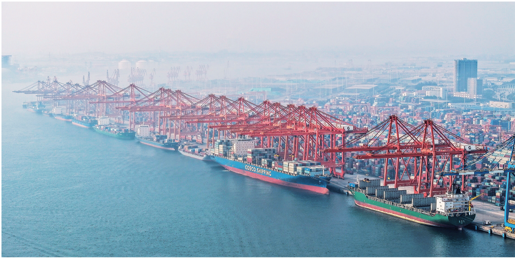
在广西钦州港码头,多艘海轮在排队卸货(无人机照片,2024年3月28日摄)。
