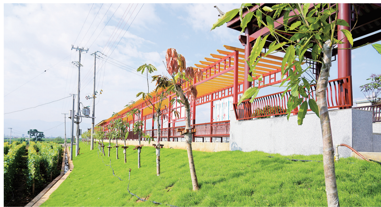
投资200余万元建设的宾川县州城镇新村广场一角。(摄于5月6日) 新村是一个移民村,1958年因宾川县修建海稍水库,乔甸镇黑龙坡等村村民,搬迁至州城。1962年9月,新村村成立。
