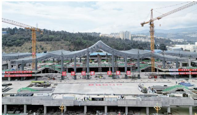
大理火车站提升改造工程施工房顶面钢网架整体提升顺利完成。(5月31日无人机航拍照片) [通讯员 丁文通 摄]
