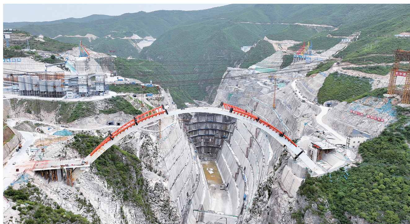
这是5月31日拍摄的陕西东庄水利枢纽泾河大桥施工现场(无人机照片)。 当日,在中铁二十局集团承建的陕西东庄水利枢纽泾河大桥施工现场,约120吨的全桥拱架吊装成功,为后续建设奠定良好基础。目前,各参建单位严格把控施工节点计划,稳步推进项目建设。 东庄水利枢纽位于陕西省咸阳市泾河峡谷,工程建成后将成为陕西省库容最大、坝高最高的水利工程。 【新华社记者 张博文 摄】
