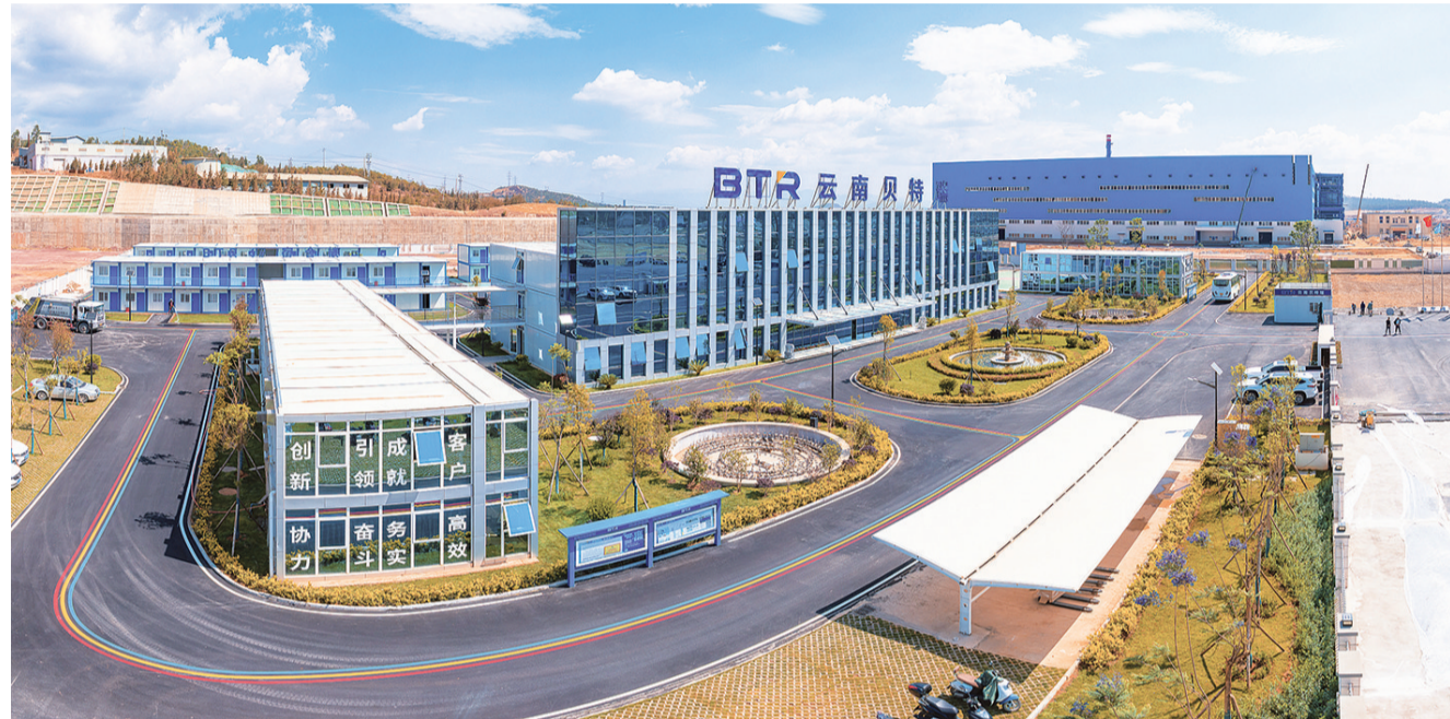
云南祥云经开区贝特瑞20万吨负极材料一体化工程一期项目。(摄于6月4日)
