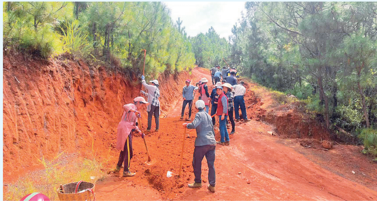
剑川县弥沙乡群众在修路施工现场平整路面。(摄于6月13日)
