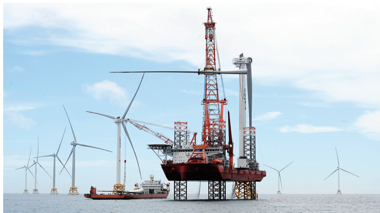
6月19日拍摄的三峡集团漳浦二期海上风电项目最后一台16兆瓦海上风电机组叶片安装现场。
