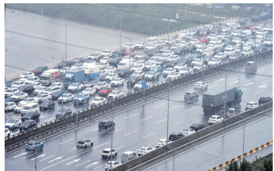
7月8日,因前方道路积水,郑州东四环高架桥车辆严重受阻。郑州市气象台7月8日6时50分继续发布暴雨黄色预警,提请注意防范强降雨引发的山洪、泥石流和城市内涝等次生灾害。【新华社记者 朱祥 摄】
