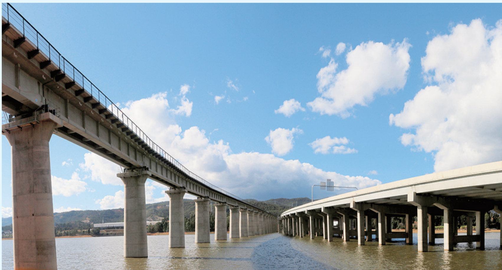
祥云经开区铁路专用线同楚(雄)大(理)高速公路并行跨越祥云县向海水库。(摄于7月9日) 祥云经开区铁路专用线全长9.5千米,是省内首条由县级政府与企业联合投资建设的专用铁路,为云南省“四个一百”重点项目和国家重点铁路专用线建设项目之一。 【通讯员 李树华 摄】
