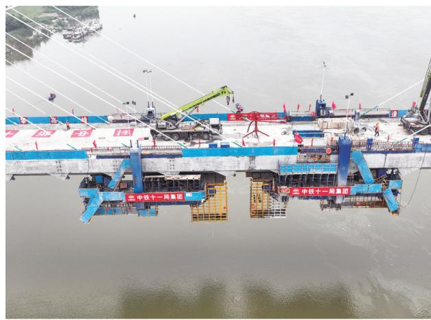
7月11日，沪渝蓉高铁钟祥汉江特大桥顺利合龙（无人机照片）。当日，中铁十一局承建的沪渝蓉高铁钟祥汉江特大桥顺利合龙，大桥实现全线贯通，为沪渝蓉高铁武宜段全线如期建成通车奠定了坚实基础。钟祥汉江特大桥主桥位于湖北荆门钟祥境内，全长547.5米，设计主跨270米，以斜拉桥形式跨越汉江航道。
