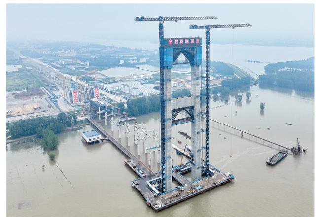
7月14日拍摄的燕矶长江大桥主塔施工现场（无人机照片）。当日，由湖北交投投资、中铁大桥局承建的燕矶长江大桥主塔全部封顶。
