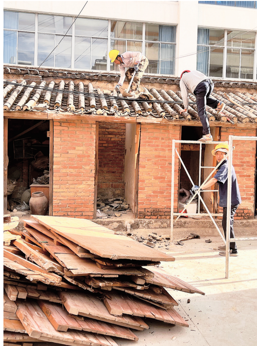
危房拆除中。(摄于7月5日)
