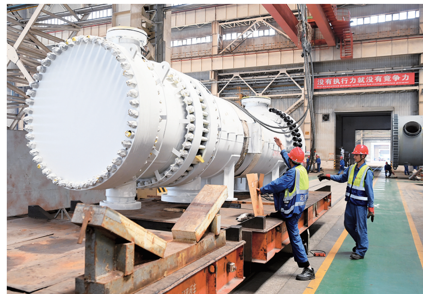
7月25日,在兰州新区兰石集团高端装备产业园,工人在吊装罐罐设备。
