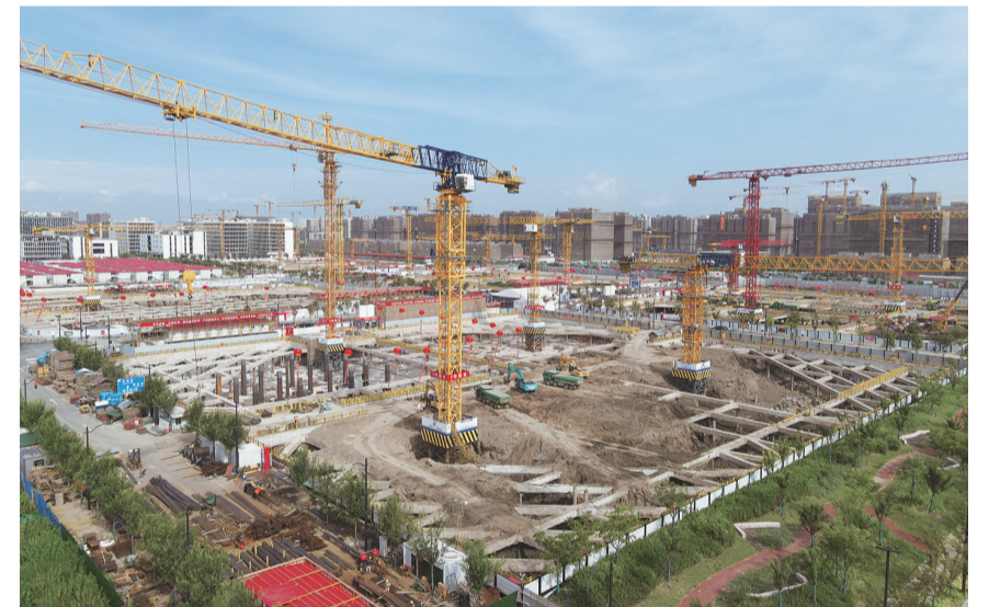
8月20日，空中俯瞰金桥临港汽车电子融合与应用研创园建设项目现场(无人机照片)。当日，中国(上海)自由贸易试验区临港新片区五周年重点项目集中开工仪式，在位于临港新片区的金桥临港汽车电子融合与应用研创园建设项目现场举行。
