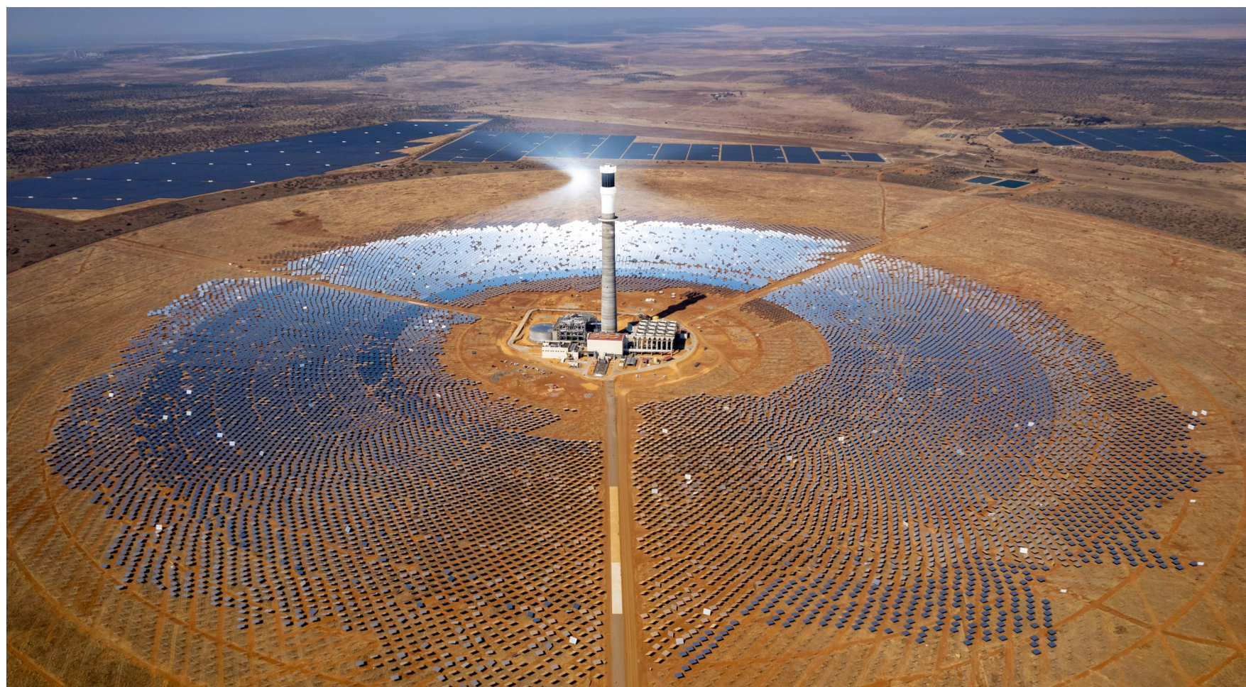
这是2024年8月20日在南非北开普省拍摄的南非红石100兆瓦塔式熔盐光热电站项目(无人机照片)。
