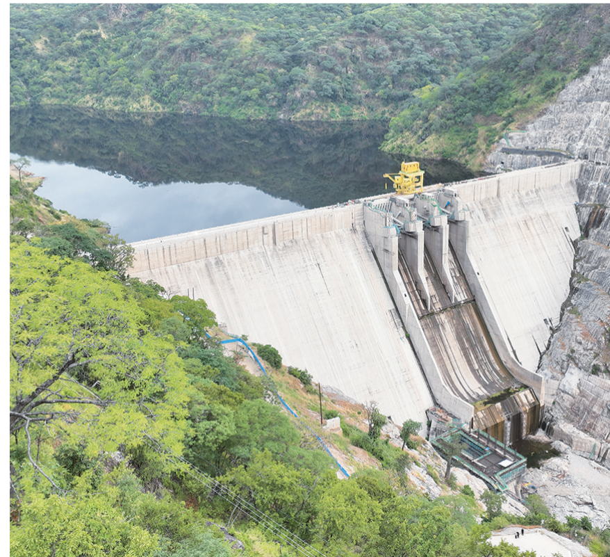
这是2023年3月23日在赞比亚南方省航拍的由中国电力建设集团有限公司承建的下凯富峡水电站大坝。
