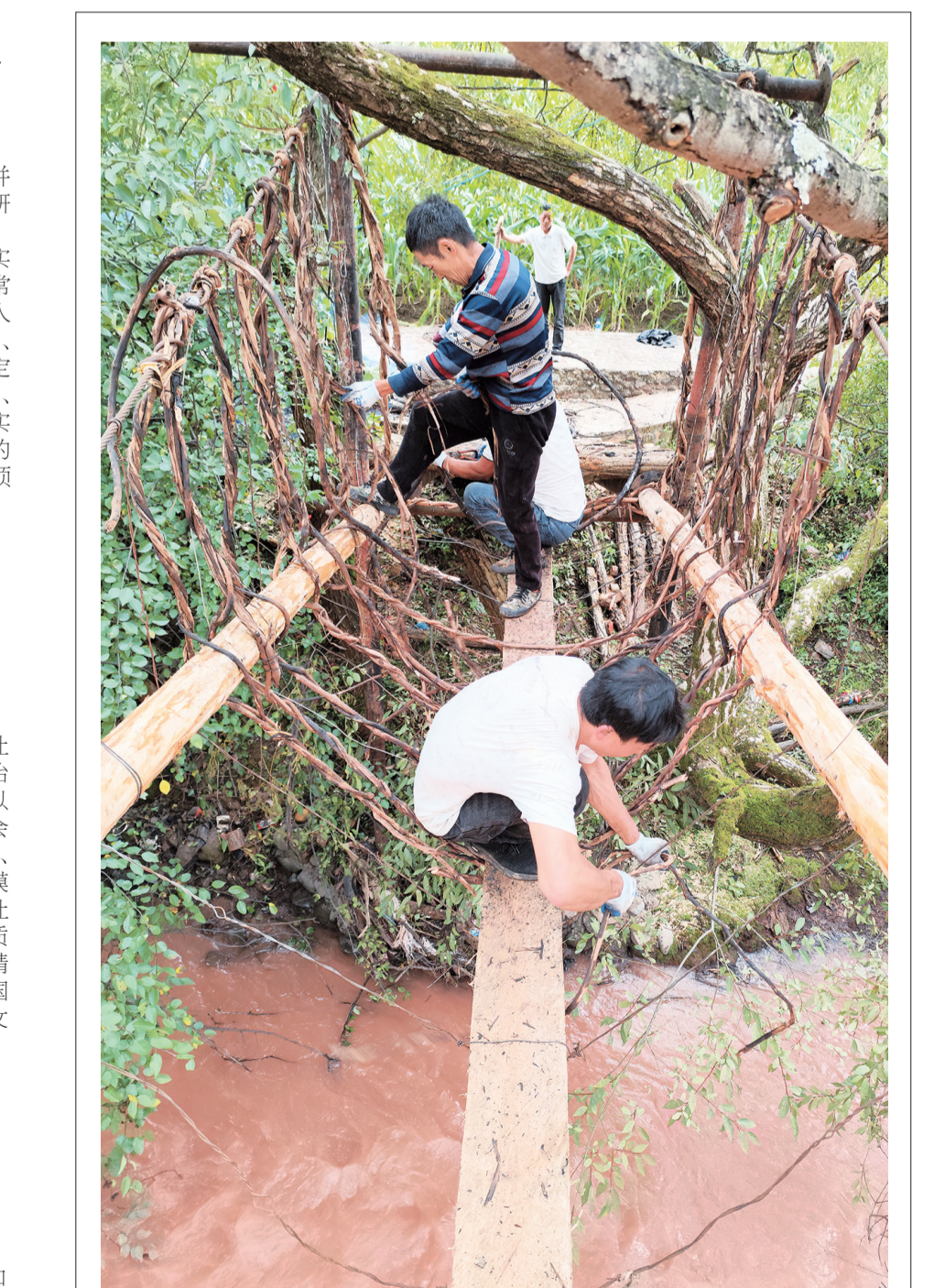
工人在修缮云龙县白石镇松水村藤桥。(摄于9月3日)
