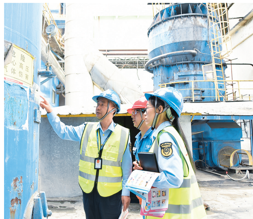
剑川县市场监管局干部深入华新水泥(剑川)有限公司对特种设备压力容器进行安全检查。(摄于9月13日)
