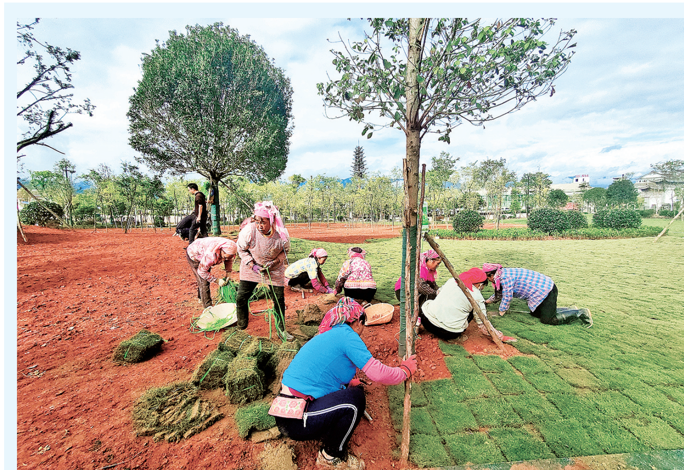
在巍山县文华山体育公园施工现场,施工人员正在紧张有序地铺设草坪。(摄于10月5日)
