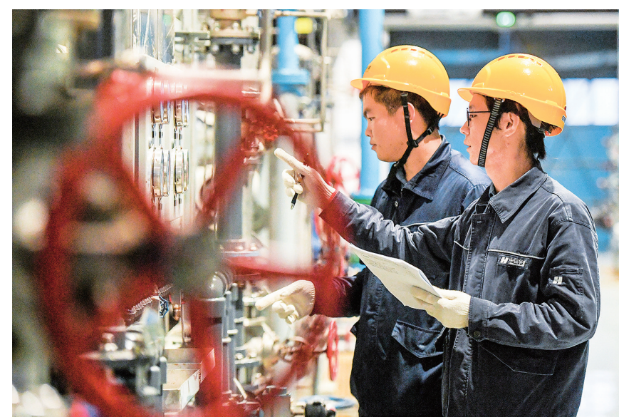
10月18日，华能山东石岛湾核电有限公司运行部技术人员在厂房内监控设备运行。位于山东省荣成市的华能山东石岛湾核电有限公司高温气冷堆核电站是我国具有完全自主知识产权的全球首座第四代核电站。
