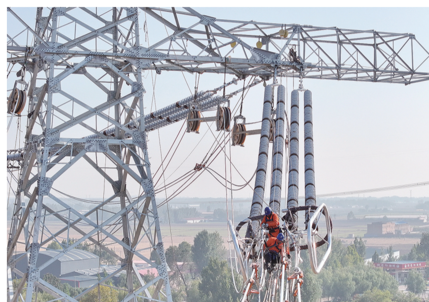
10月23日,工人在河北磁县磁州镇境内的陇东至山东800千伏特高压直流线路工程河北段跨京广铁路建设工地施工(无人机照片)。近日,陇东至山东800千伏特高压直流输电线路工程河北段建设正在按照节点要求稳步推进。据国网河北建设公司介绍,陇东至山东800千伏特高压直流输电线路起于甘肃庆阳换流站,终点至山东泰安东平换流站。该特高压线路途经甘肃、陕西、山西、河北、山东5省,线路全长926公里,可将甘肃陇东地区的煤电、风电、光伏发电联合送出,实现更大范围电力资源优化配置。【新华社记者 杨世尧 摄】
