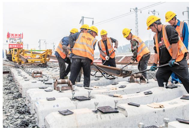
11月2日，渝昆高铁重庆东站施工现场，工人在机械的辅助下进行铺轨作业。当日，在渝昆高铁重庆东站施工现场，随着第一组500米长钢轨稳稳落下，渝昆高铁重庆东至黔江段铺轨工程全面进入攻坚阶段。渝昆高铁重庆东至黔江段全长269.5公里，是国家中长期铁路网规划的“八纵八横”高铁网中渝昆通道的重要组成部分。此次铺轨的是重庆东站引出至武隆区白马山隧道出口方向，由中铁十一局承担，其中正线铺轨长度为236.274公里，站线铺轨长度为4.18公里，有砟道岔5组，无砟道岔26组。
