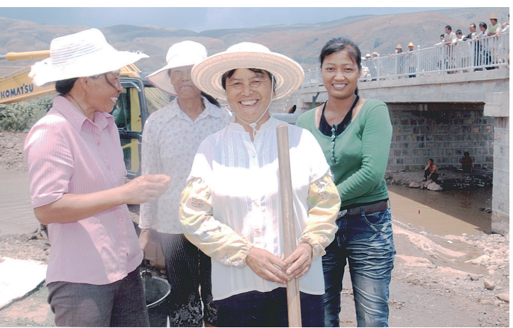
宾川县力角镇洪福桥近日竣工,乡亲们为不再涉险过河由衷喜悦。以往当地群众涉水过河,汛期时有险情发生。通过村民一事一议,决定修双孔水泥石桥,群众集资15万元,财政奖补40万元。去年12月开工,近期验收。新桥落成大大方便了当地群众出行。 [韩如龙 摄]
