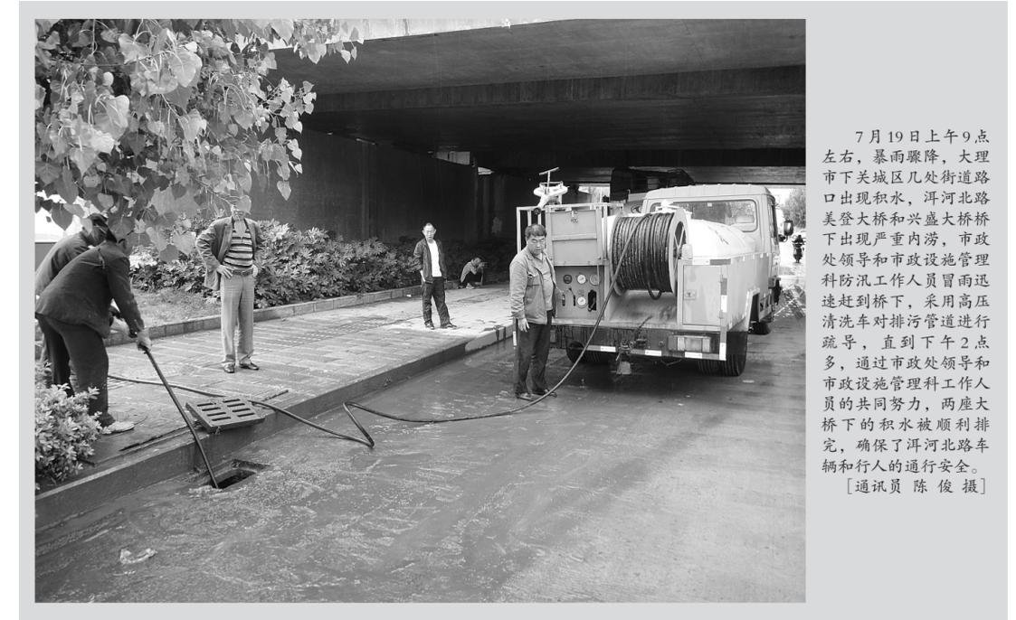
7月19日上午9点左右,暴雨骤降,大理市下关城区几处街道路口出现积水,洱河北路美登大桥和兴盛大桥桥下出现严重内涝,市政设施管理科防汛工作人员冒雨迅速赶到桥下,采用高压清洗车对排污管道进行疏通,直到下午2点多,通过市政设施和市政设施管理科工作人员的共同努力,两座大桥下的积水被顺利排完,确保了洱河北路车辆和行人的通行安全。
