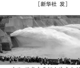
昨日,游客在黄河小浪底水利枢纽工程观看飞瀑景观。当日,2014年黄河小浪底调水调沙正式开始。本次调水调沙将实施黄河万家寨、三门峡、小浪底3座水库水沙联合调度,将黄河下游主河槽的过流能力提高,利用“人造洪峰”将下游河床淤积的泥沙送入大海,同时减少小浪底水库的泥沙淤积。自2002年开始,黄河小浪底水库已实施14次调水调沙。
