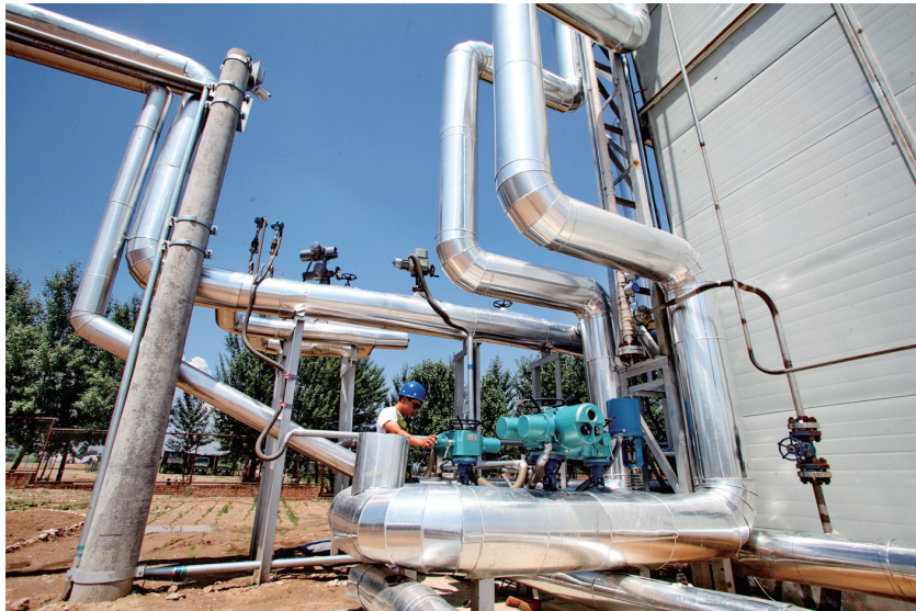
在河北省宣化县,工人在北京兆阳光热技术有限公司建设的光热发电站工作(6月30日摄)。
