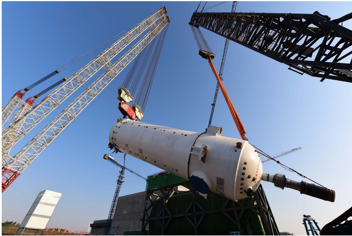
昨日，在山东石岛湾核电站，反应堆压力容器在吊装中。
