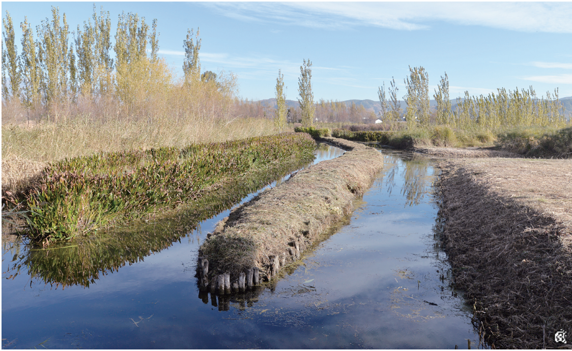
①、② 群众正在进行枯死水草清除工作。 ③ 经过清理的河道。
