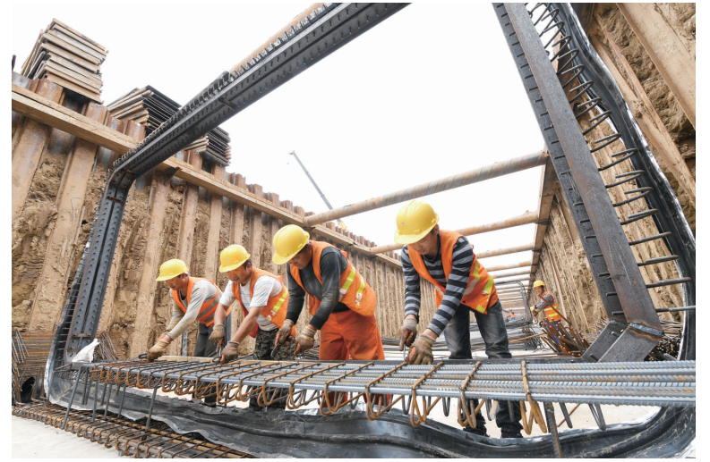
昨日，工人在河北省辛集市工业路管廊工程建设工地作业。为解决城市排水难题，2018年以来，河北省辛集市对市区多条路段进行排水设施建设，并实施汛前排水管网清淤和重点积水点整治。根据规划，项目完工后可解决辛集市区17平方公里区域的排水问题，有效改善雨季积水现象。【新华社记者 牟宇 摄】
