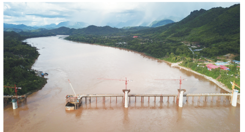
这是7月11日在老挝琅勃拉邦省拍摄的中国中铁八局承建的中老铁路琅勃拉邦湄公河特大桥主桥施工现场。 中老铁路琅勃拉邦湄公河特大桥主桥最后一个承台当地时间7月10日深夜顺利浇筑完成,这标志着中老铁路跨湄公河的两座特大桥主桥基础施工全面完成。 【新华社 发】
