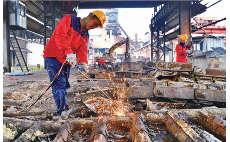
昨日,工人在唐山市一家停产的钢厂拆除炼钢设备。 记者从河北省政府获悉,今后三年,河北省将继续坚定不移推进去产能工作,实施“432511”工程,即压减退出钢铁产能4000万吨、煤炭3000万吨、平板玻璃2300万重量箱、水泥500万吨、焦炭1000万吨、火电150万千瓦。 【新华社记者 杨世尧 摄】
