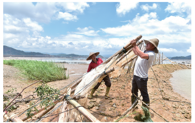
昨日,福鼎市点头镇龙田村青头自然村村民薛敬闻(右)和薛家回在修复被台风冲毁的滩涂围网。 台风“玛莉亚”给福建的农业、交通、水利、电力等方面造成不同程度的损失。台风过后受灾地迅速开展生产自救,尽快恢复生活生产秩序。 【新华社记者 林善传 摄】
