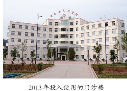
2013年投入使用的门诊楼
