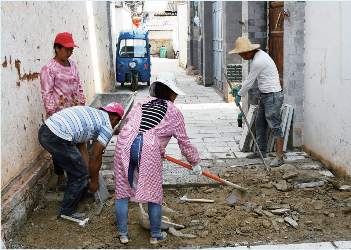
8月22日,大理市挖色镇康麻村村道路青石板铺设工程正在加紧施工。
