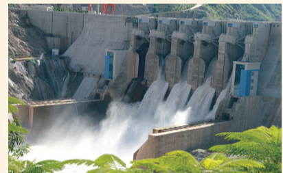
鲁地拉水电站是金沙江上游重要水电项目,为做好项目服务,建行在此设立机构,以金融的力量解决重点建设的困难,综合性专业化的服务助推项目建成。
